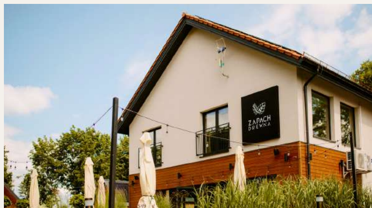
BUDYNEK GŁÓWNY OŚRODKA
